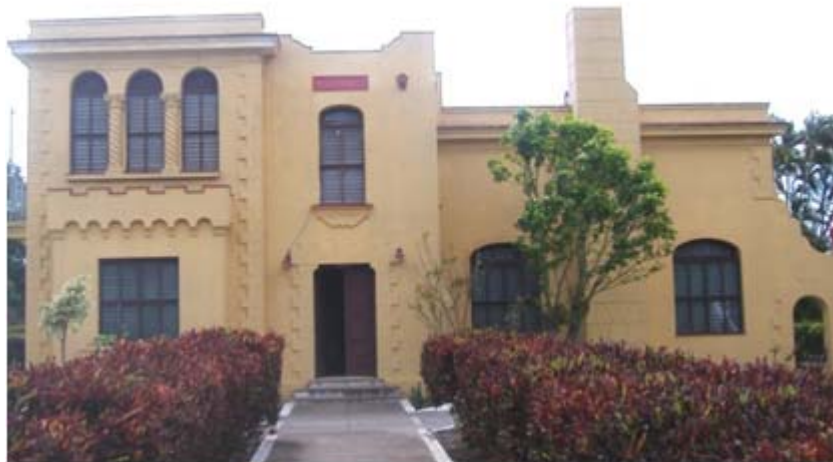
Fig. 38. Casa vivienda del central Perseverancia que sustituyó en la década del cuarenta a una existente de los orígenes de la industria.
