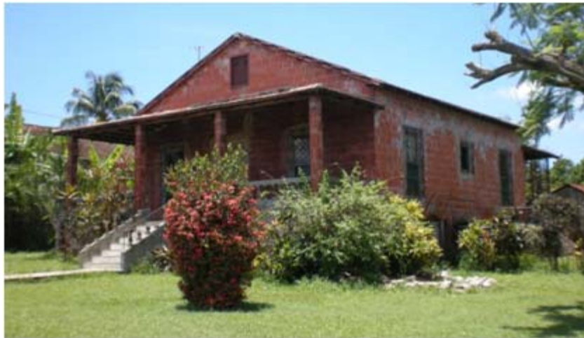
Fig. 37. El uso del ladrillo a vista en las viviendas de empleados, las grandes pendientes de sus cubiertas y la jardinería integra urbanísticamente el conjunto del batey Constancia.
