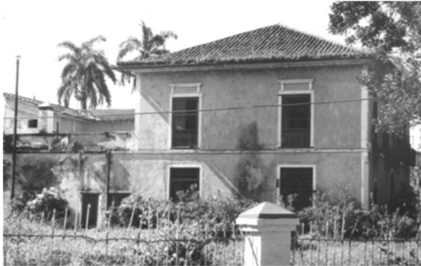
Fig. 3. Vista de los laterales de la vivienda con las características de la cubierta de su cuerpo delantero y donde se observan las cubiertas del segundo nivel de la parte posterior que vierten hacia su patio central.
