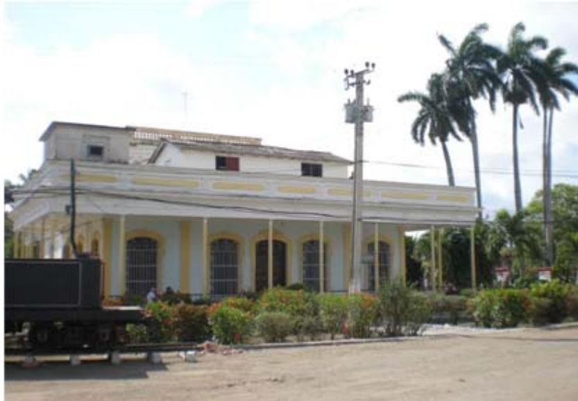
Fig. 31. Fachada principal de la vivienda de los propietarios del central Andreita (Mal Tiempo) con agregados recientes en el nivel de cubierta de su cuerpo frontal que la devalúa. La palma real forma parte de los jardines laterales de la casa.
