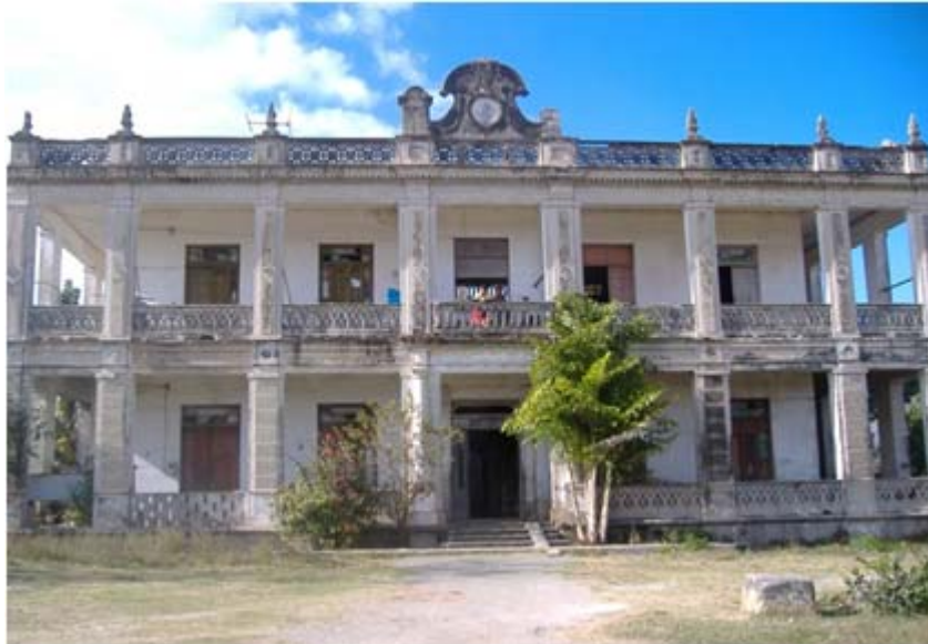
Fig. 33. Fachada principal de la casa vivienda del central Lequeitio.
