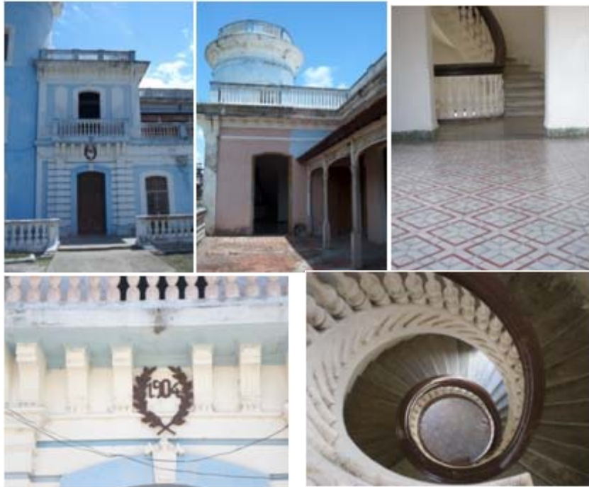
Figs. 26, 27, 28, 29 y 30. Detalles de la vivienda. Acceso, galería y terraza en el segundo nivel, pisos de mosaico, escudo que refleja la fecha de construcción del inmueble y escalera.
