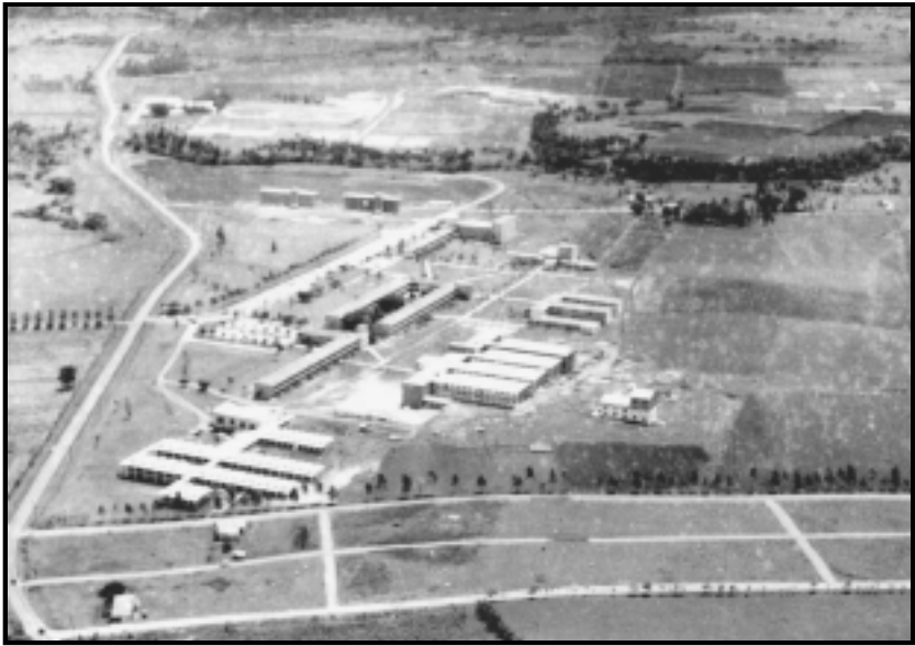
Figura 1. Vista aérea de las obras de los primeros años después del triunfo de la Revolución. (Fuente: fotografía de archivo.)
