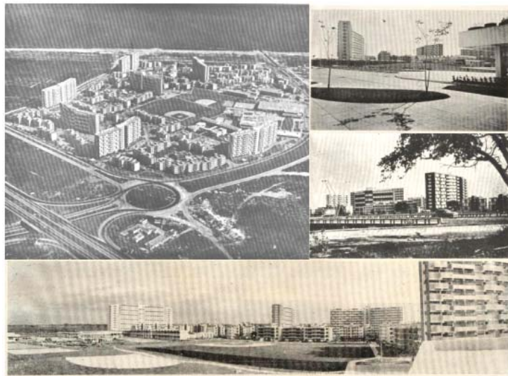
Figura 1. Unidad Vecinal de La Habana del Este
