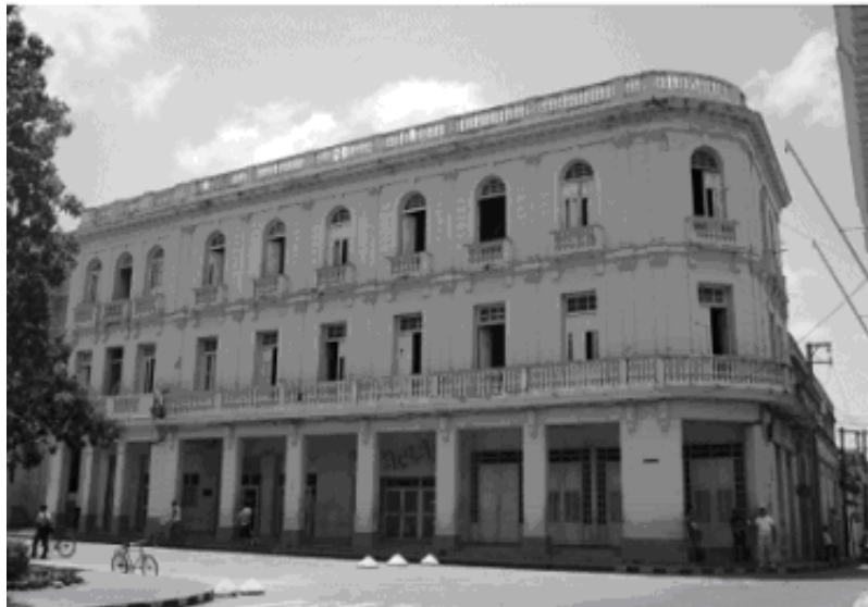
Hotel Florida. Nótese la diferencia en el ritmo de los vanos de fachada de la parte original (tres ventanas del extremo izquierdo) con el resto de la edificación
