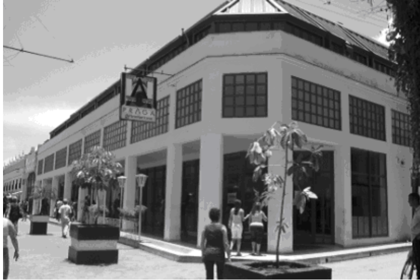
Figura 9. Tienda Praga, ubicada entre las calles Villuendas y Máximo Gómez, proyectada por el Arq. José Antonio Choy
