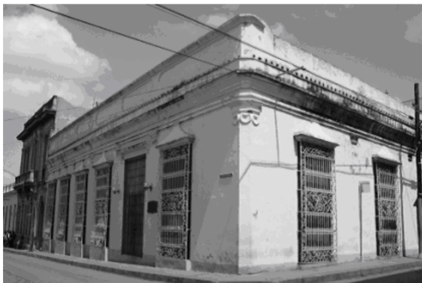
Figura 5. Casa de la Ciudad, ubicada en la calle Independencia, esquina a la calle Juan Bruno Zayas
