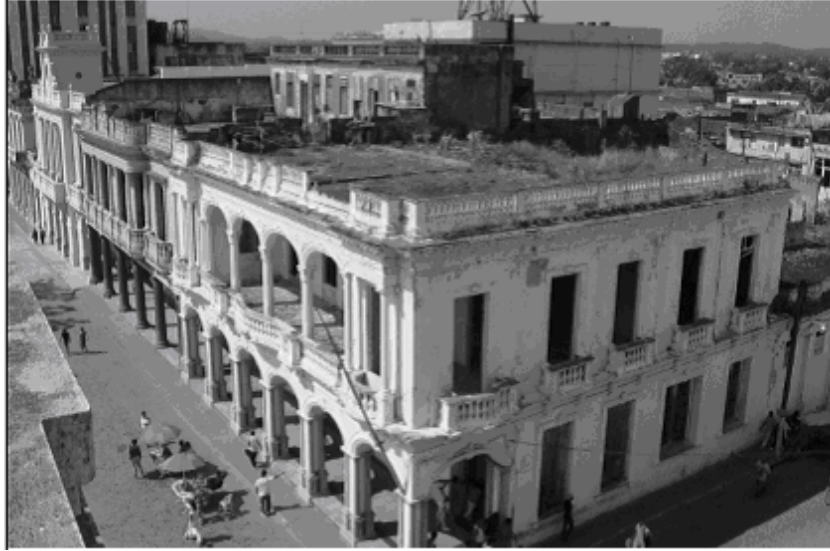
Figura 5. Imagen antes de iniciar las tareas de recuperación
