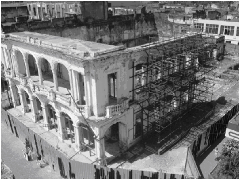
Figura 6. Imagen después de sanear el edificio y consolidar sus fachadas
