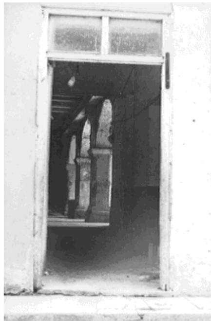
Figura 8. Galería apoyada en arcos de medio punto y columnas de orden toscano, único testigo actual del edificio original
